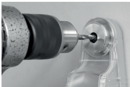
Fig. 4 – Realizando a perfuração
