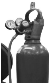
Fig. 3 – Instalación del gas
