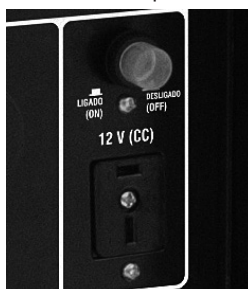
Figura 15 – Disjuntor do circuito CC
