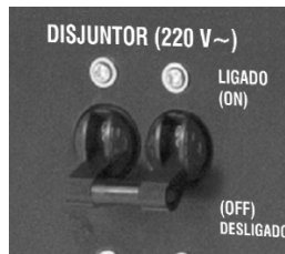
Figura 13 – Disyuntor del Circuito CA
