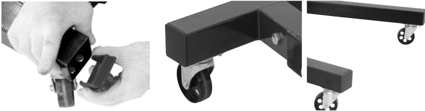
Figura 11 – Instalación de las tapas de goma
